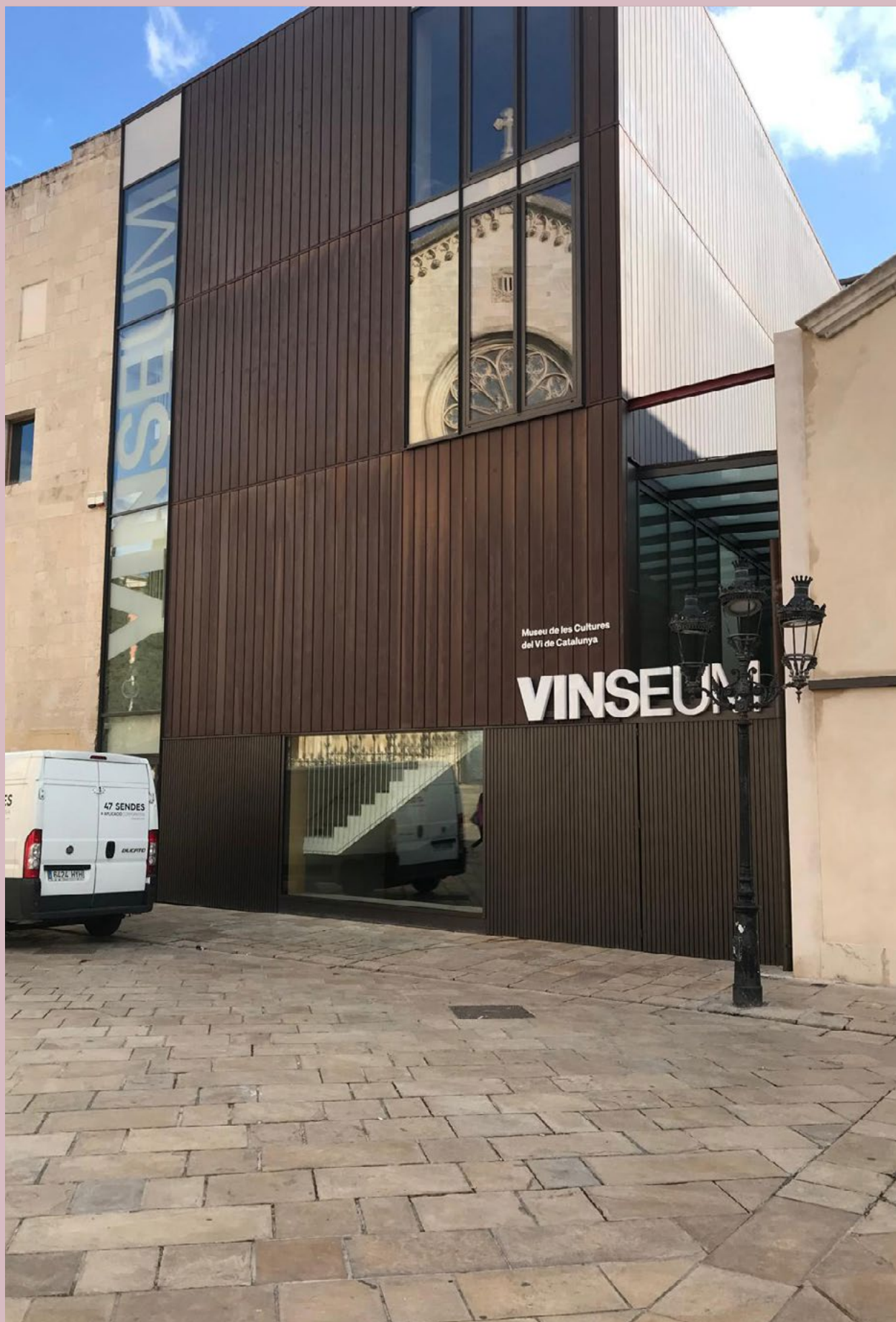
Muntatge rètol façana
