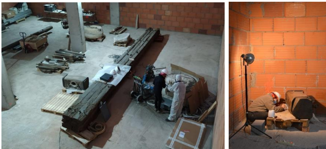
Vista general espai de treball i consolidació femella.
