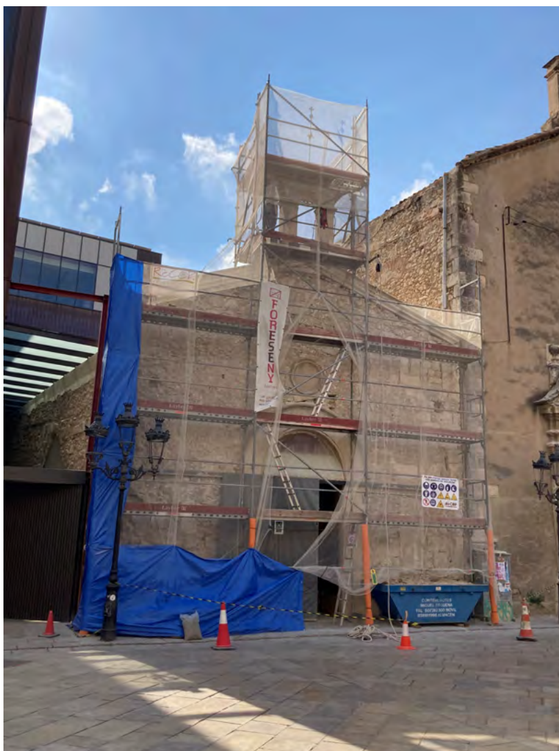
Capella de Sant Pelegrí, procés de restauració de la façana principal.
