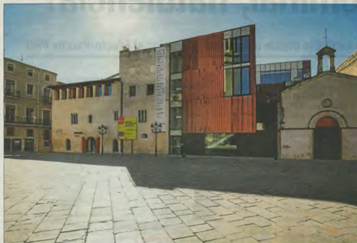
Una vista de la façana del Palau Reial i la capella de Sant Peregrí, amb el nou edifici que s'obrirà, al mig. CEDIÀ PER VINSEUM
