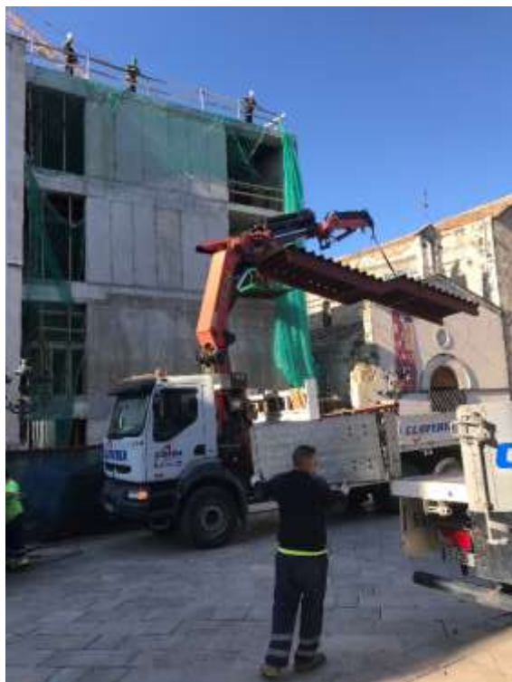
(a sobre) Façana principal de l'edifici, moment d'arribada i descàrrega de l'escala metàl·lica de l'edifici posterior.
